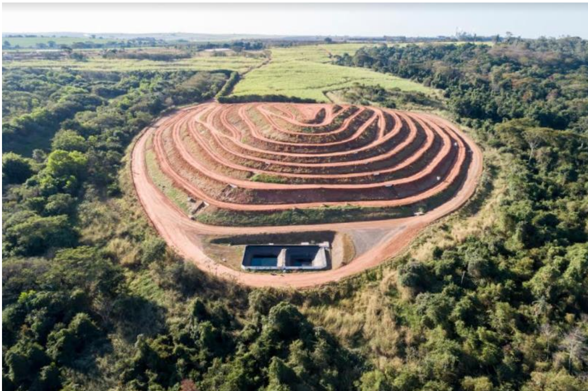
Foto 03 - Aterro Sanitário de Catanduva.
