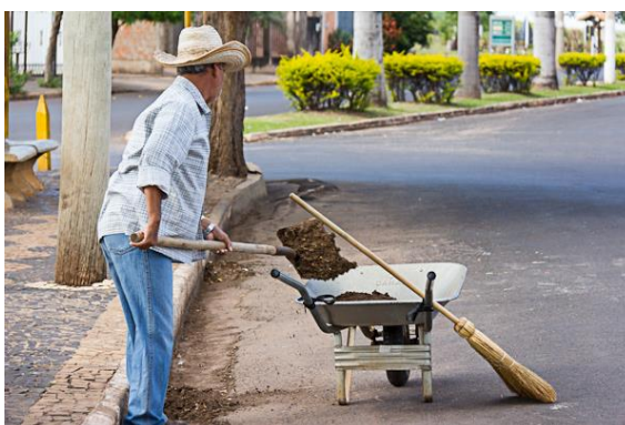
Foto 10 - Serviço de Raspagem
